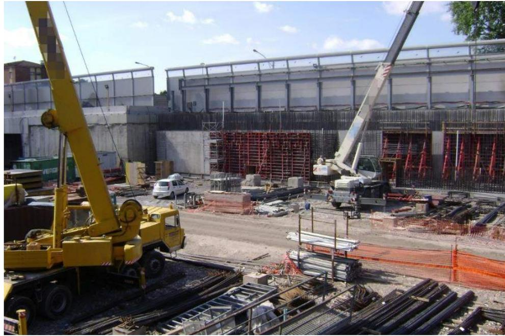
Fase di lavoro molto pericolosa, per la quale necessita il progetto a firma di un professionista abilitato con cui viene attestata la conformità dell'elemento (lunghezza, diametro, spessore e numero degli elementi, ecc.), che viene posto a sostegno della gabbia di armatura nella fase di sospensione.
